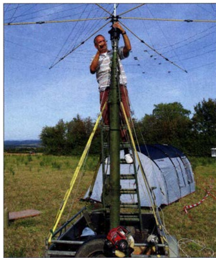
Eugen, DL8AAI, bei der Antennenmontage auf seinem Kurbelmast
